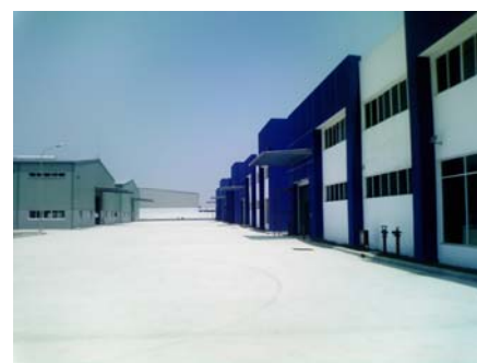
<工場団地内コンテナ通路>
