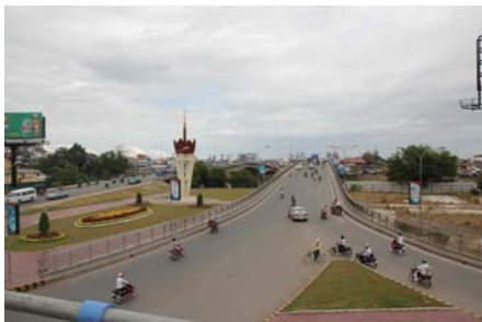
カンボジア・プノンベンの橋梁 (撮影 2012年1月)
