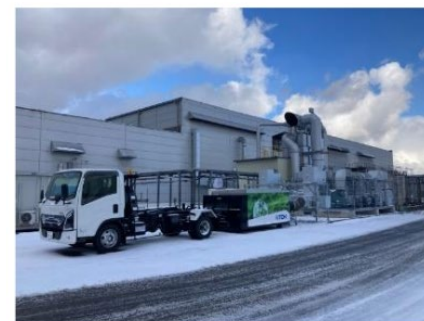
A: 排熱場所 外観 (排熱を回収)
